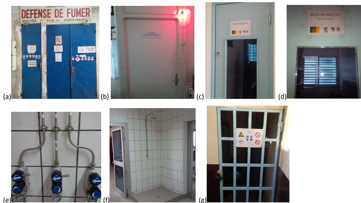
Photo 5 : quelques dispositifs de sécurité en place dans les laboratoires visités (a) les pictogrammes et affiches de sécurité au Labo Hydrac ; (b) luminaire de présence d'opérateur au Labo Hydrac ; (c)(d) salles compartimentés en fonction des opérations avec porte coupe-feu munis de ressort de rappel au Labo Irad ; (e) la tuyauterie en inox récemment installé au Labo-Reg ONCC ; (f) douche de lavage d'opérateur en cas d'exposition au Labo-Reg ONCC; (g) bloc de bouteille de gaz à l'extérieur du bâtiment au Labo Irad.
